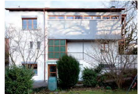
WOHNHAUS VON 1941 Kleine Massnahme mit grosser Wirkung
