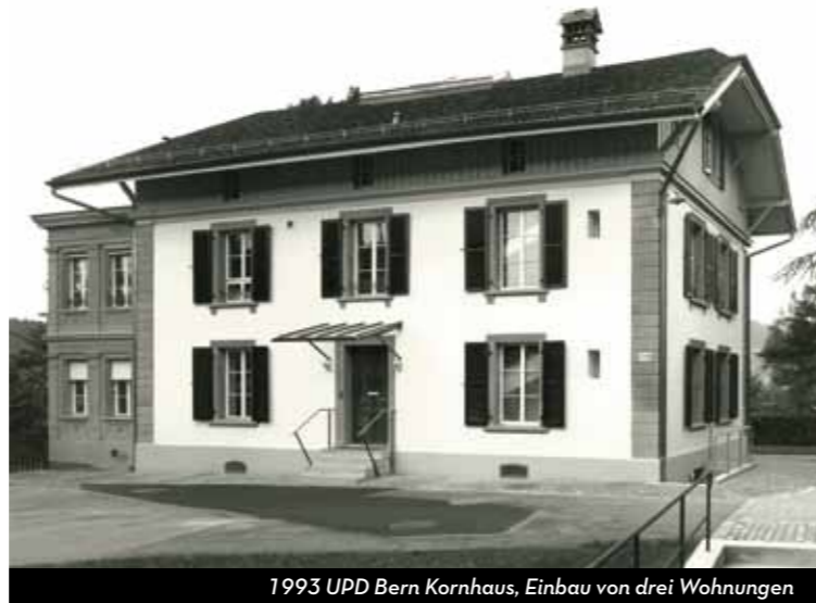
1993 UPD Bern Kornhaus, Einbau von drei Wohnungen
