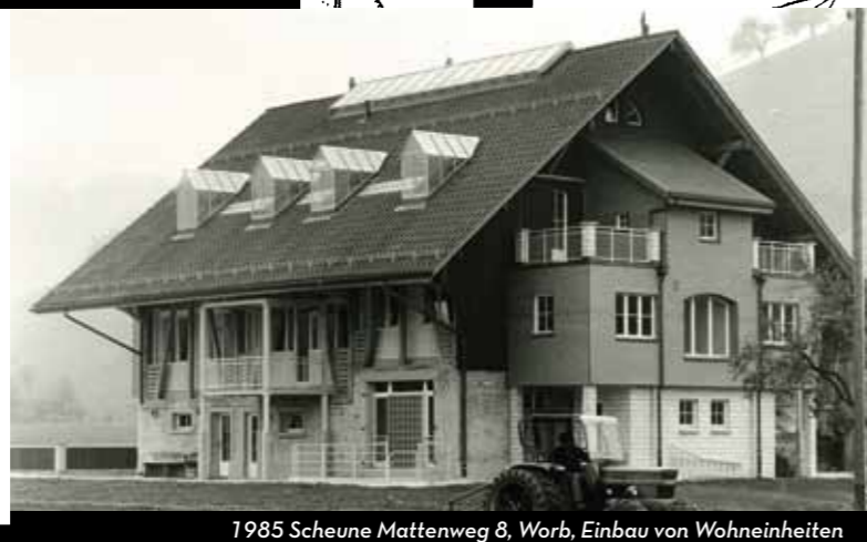
1985 Scheune Mattenweg 8, Worb, Einbau von Wohneinheiten
