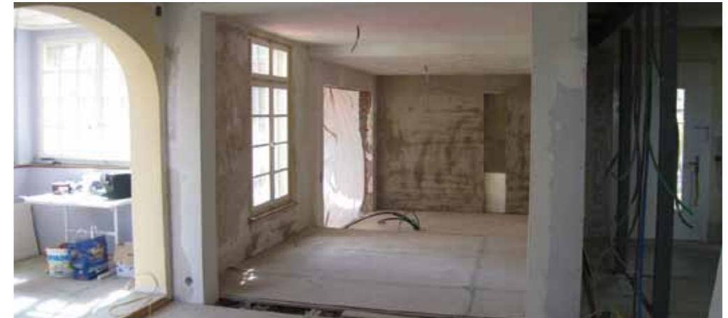
2013 Umbau & Renovation Wohnhaus Jungfraustrasse 7, Thun
