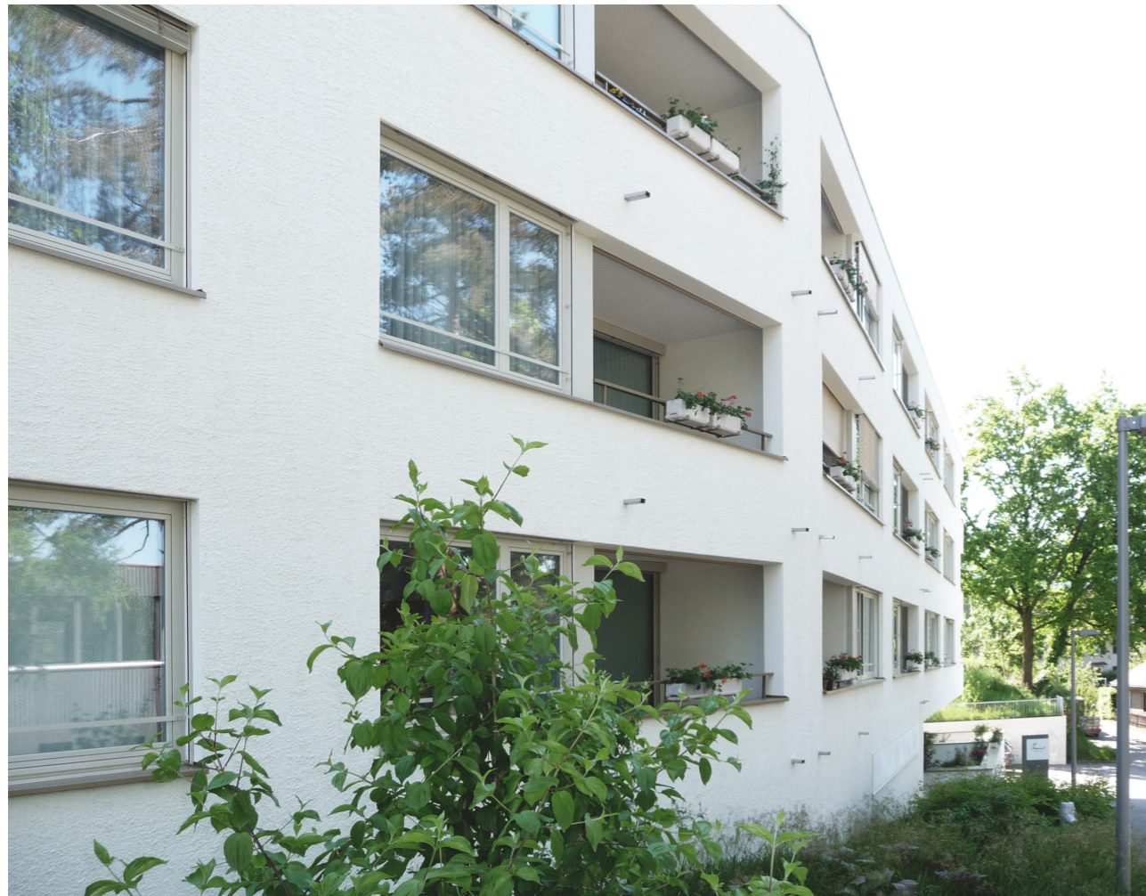
Das Gebäudeensemble mit den beiden Gebäuden des Alterszentrum Lentulus erstreckt sich entlang des Lentulushügels und umfasst 42 Alterswohnungen und 3 Pflegeabteilungen.
